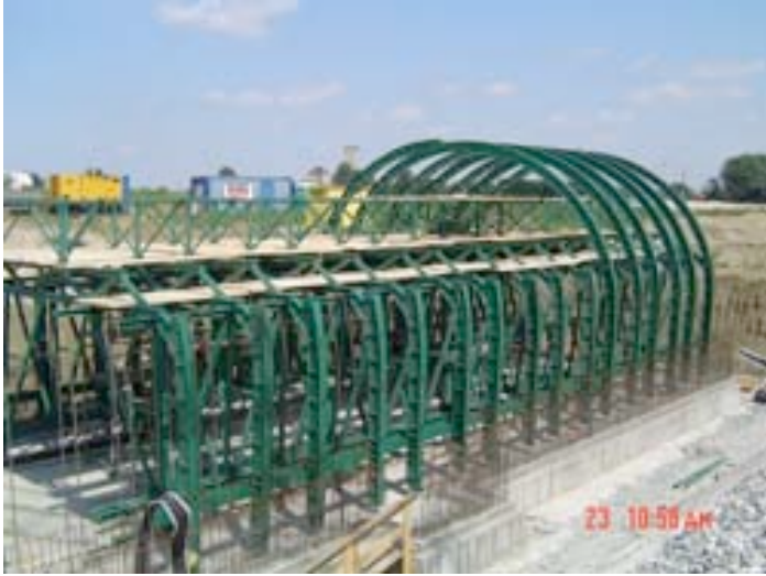
3. Setzen der gebogenen Holme
